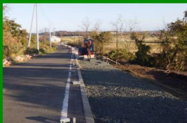
① 取付道路拡幅部の路盤工を行っています。
